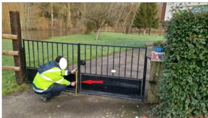
laisse de crue à 32 cm/sol.
