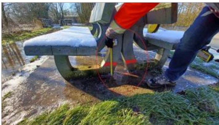
Laisse de crue à 14 cm/sol
