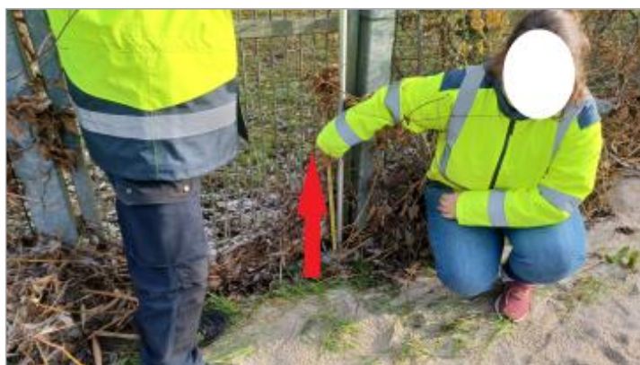
Laisse de crue à 40 cm/sol
