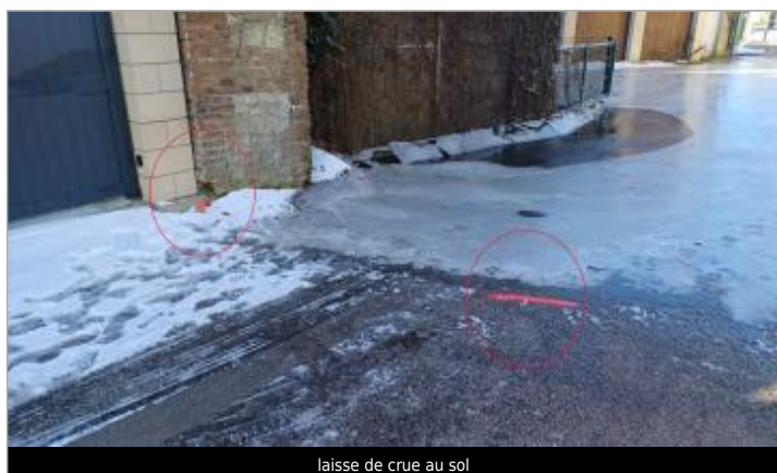
laisse de crue au sol
