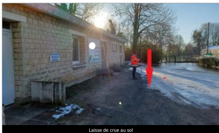
Laisse de crue au sol
