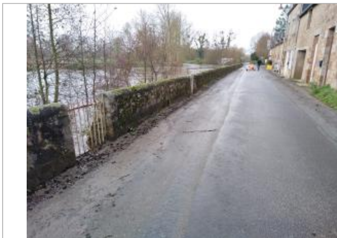
vue depuis la rue "Le Pavement"
