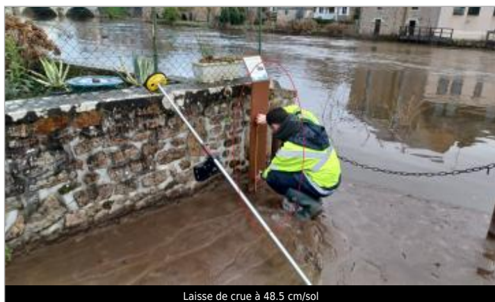
Laisse de crue à 48.5 cm/sol
