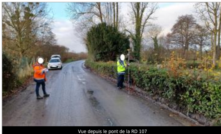
Vue depuis le pont de la RD 107
