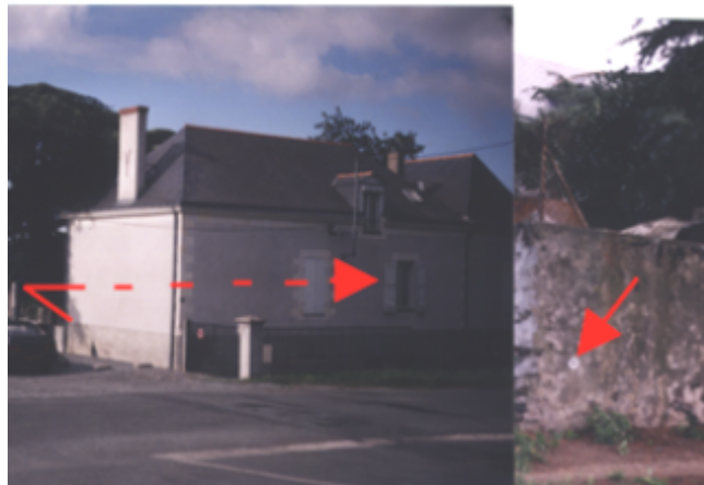
Vue du cheminement topo : BDHE 352 point de repère 492 (source: DIREN Centre)
