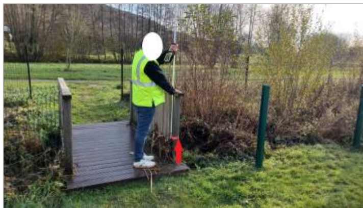
laisse de crue à environ 40 cm/sol du pont
