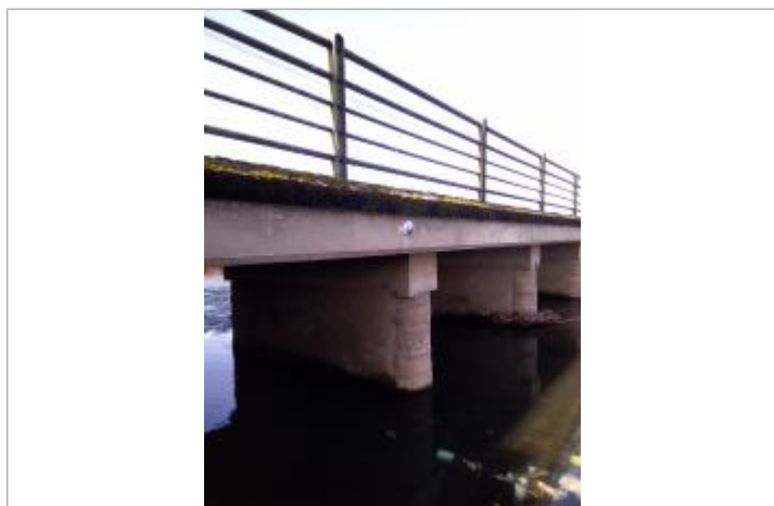
Vue du repère - Auteur : SMBGP
