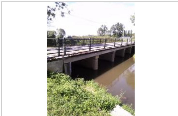
Vue du site - Auteur : SMBGP
