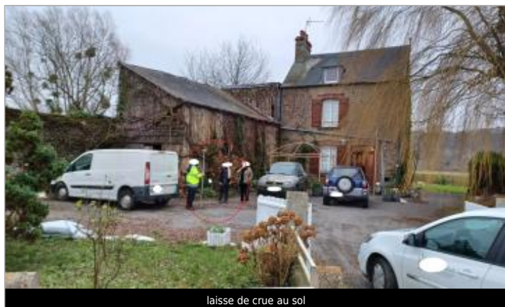
laisse de crue au sol
