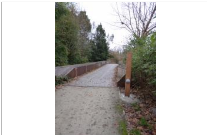
Vue du site - Auteur : SMBGP
