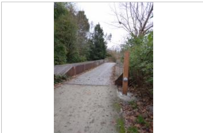
Vue du site - Auteur : SMBGP
