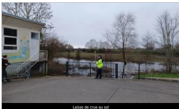
Laisse de crue au sol
