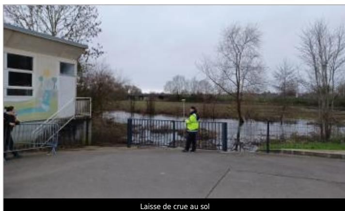
Laisse de crue au sol
