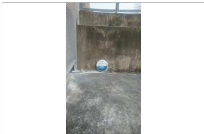
Vue du repère - Auteur : SMBGP
