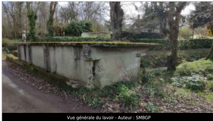
Vue générale du lavoir - Auteur : SMBGP
