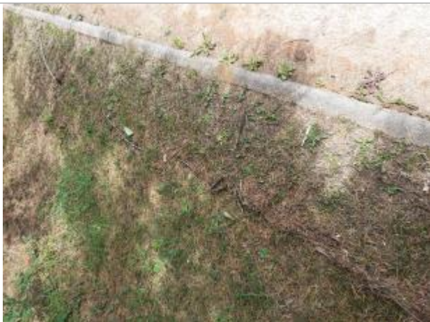
axe de ruissellement sur la route de Maromme matérialisé par laisse de végétation sur bande enherbée
