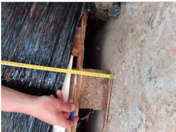
13 cm à partir du sol du garage (témoignage habitant)
