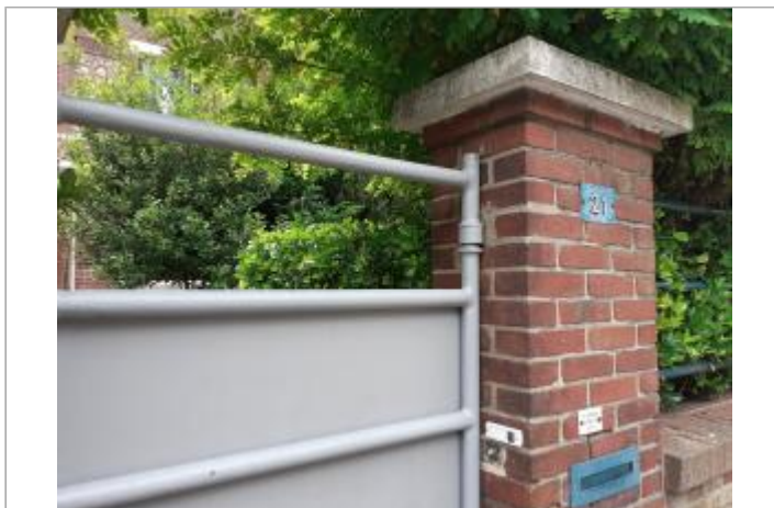
portail d'entrée donnant sur la rue
