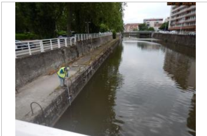
Vue du site éloignée
