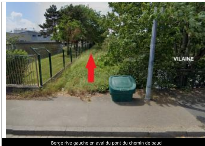
Berge rive gauche en aval du pont du chemin de Baud
