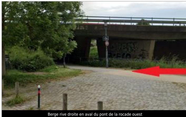
Berge rive droite en aval du pont de la rocade ouest
