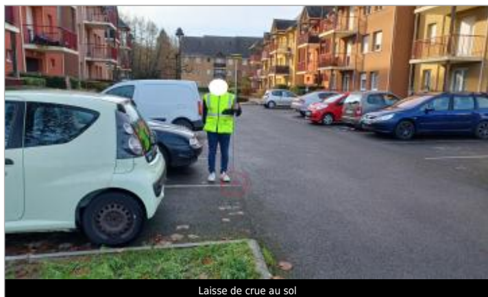
Laisse de crue au sol
