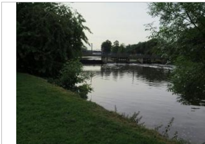
Passerelle sur la Vilaine sur l'île du Comte
