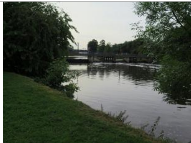
Passerelle sur la Vilaine sur l'île du Comte
