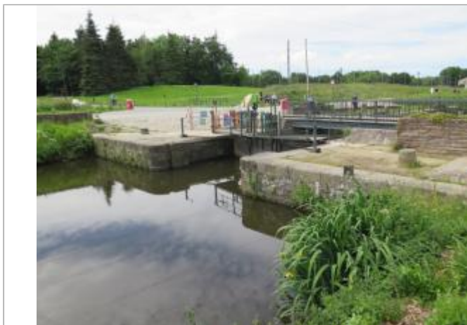
Vue générale de l'écluse du Comte Amont à Rennes
