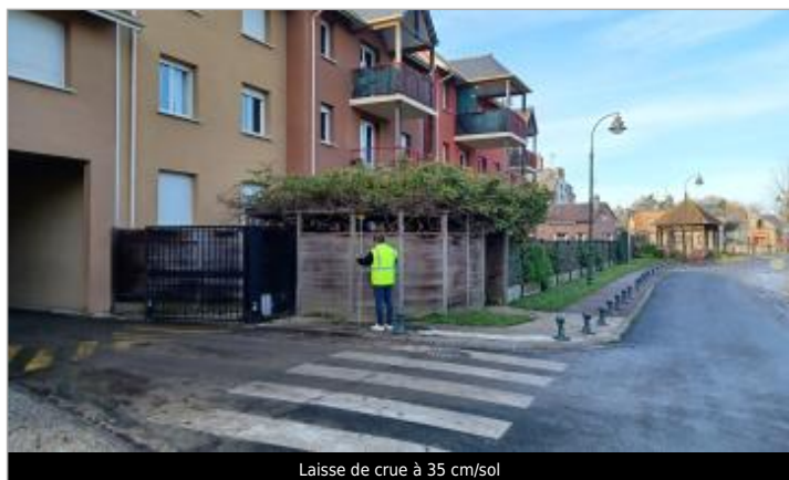
Laisse de crue à 35 cm/sol
