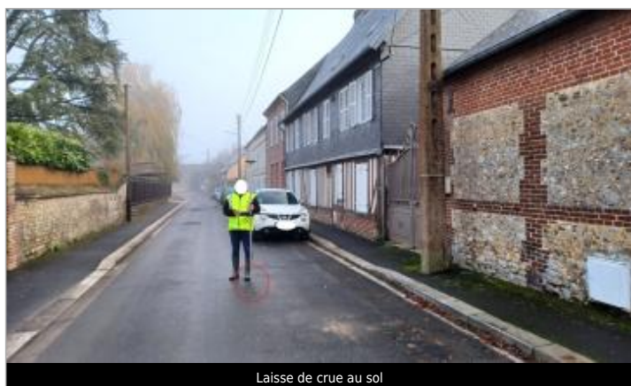
Laisse de crue au sol
