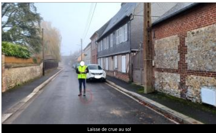
Laisse de crue au sol
