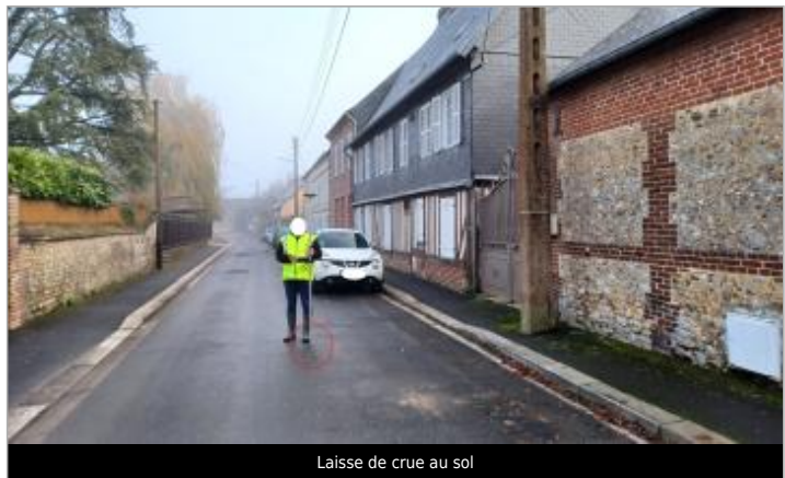
Laisse de crue au sol
