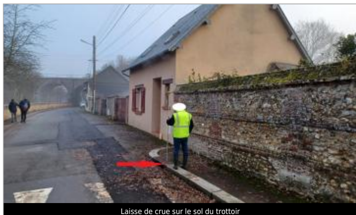
Laisse de crue sur le sol du trottoir
