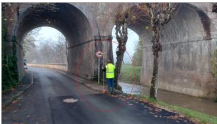
Laisse de crue au sol.
