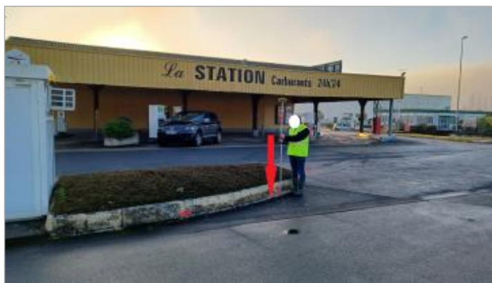
Laisse de crue au sol
