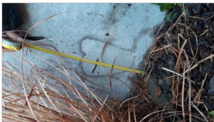
Laisse de végétation sur le mur à 22 cm du sol à partir de la bordure béton
