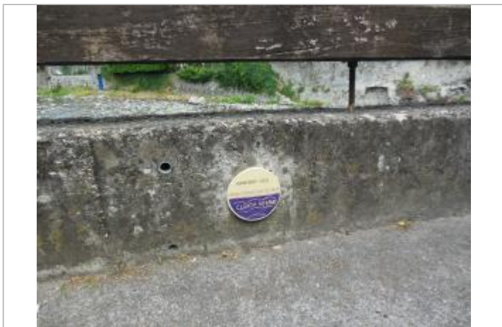
Repère posé sur le muret
