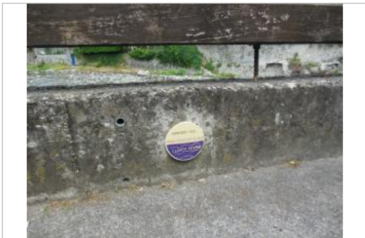
Repère posé sur le muret
