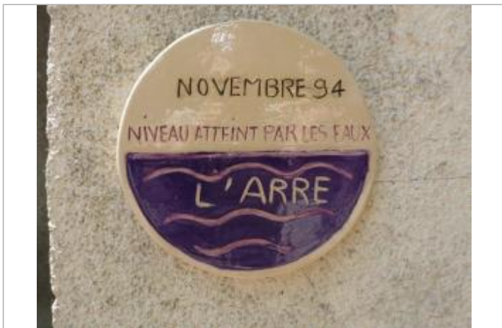
Repère posé sur le bâtiment des vestiaires
