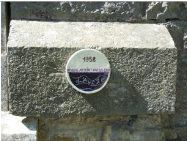
Repère posé sur une pile du pont
