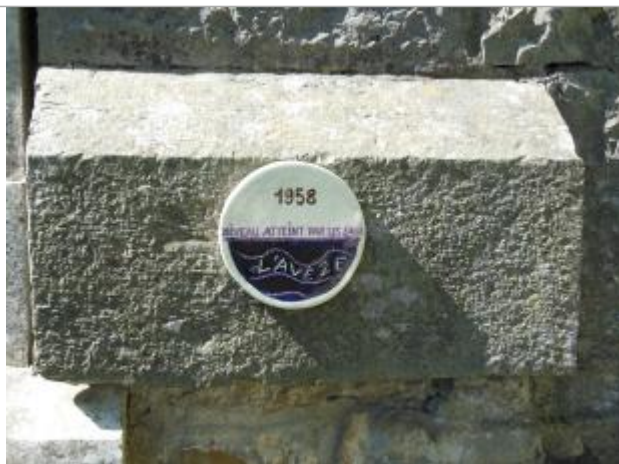
Repère posé sur une pile du pont
