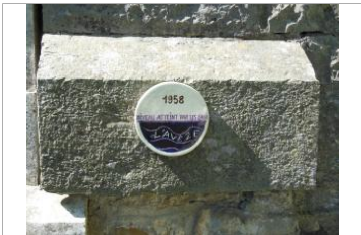
Repère posé sur une pile du pont
