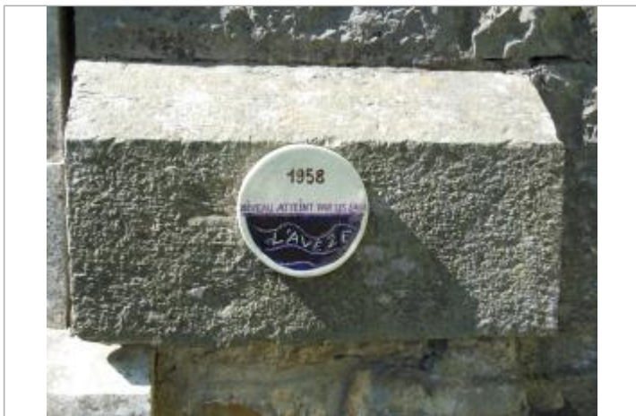
Repère posé sur une pile du pont
