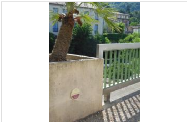
Repère posé sur un muret
