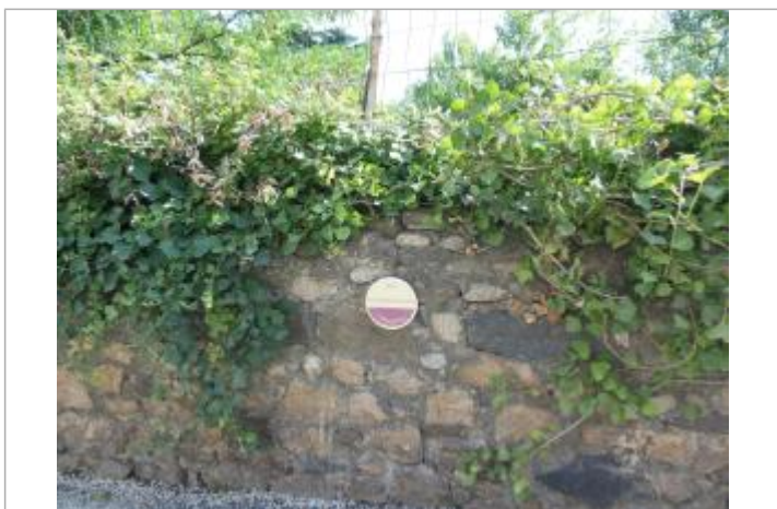
Repère posé sur le muret
