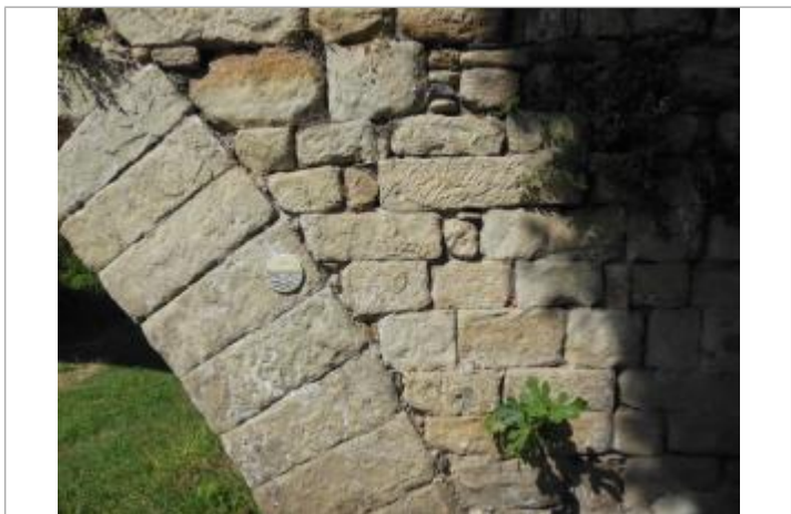
Repère posé sur une pile du pont
