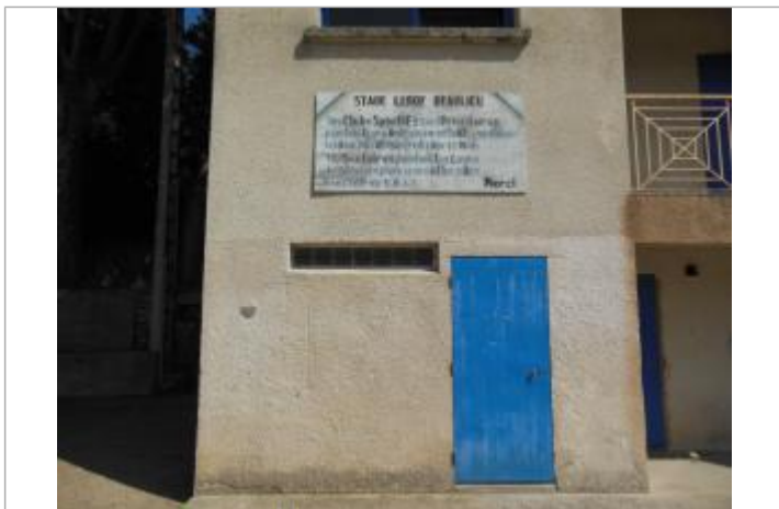
Repère posé sur un bâtiment du stade
