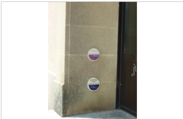
Repère posé à l'entrée du bâtiment
