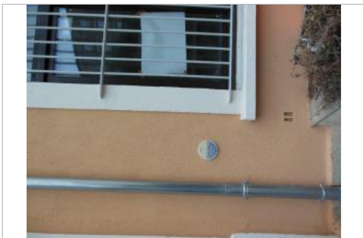
Repère posé sur le bâtiment de la mairie
