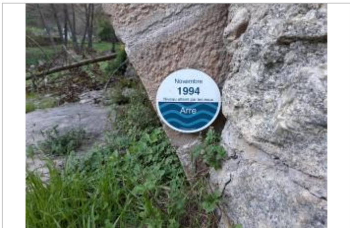
Repère posé sur une pile du pont
