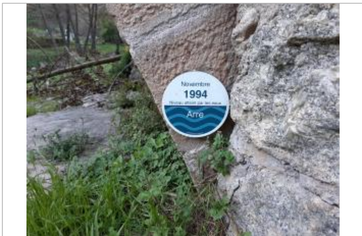
Repère posé sur une pile du pont
