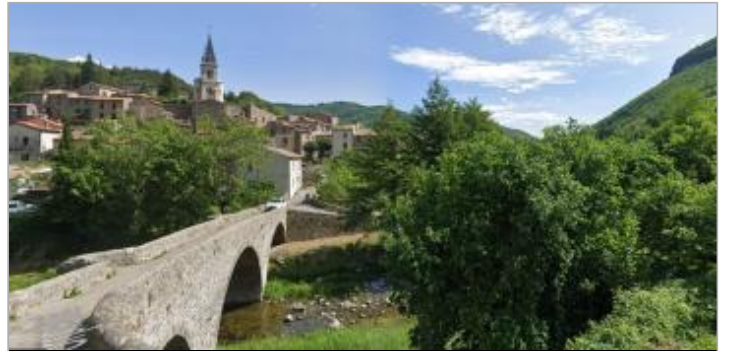
vue du site pile du pont
