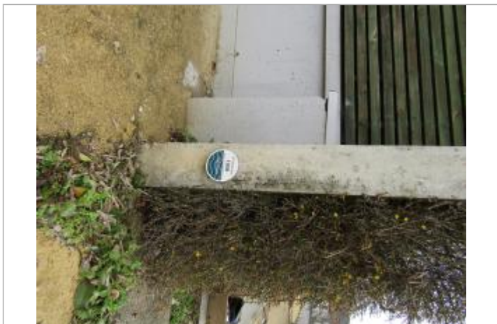
Repère posé sur le bâtiment de la halle des sports
