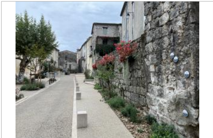
mur d'enceinte avec plusieurs repères
